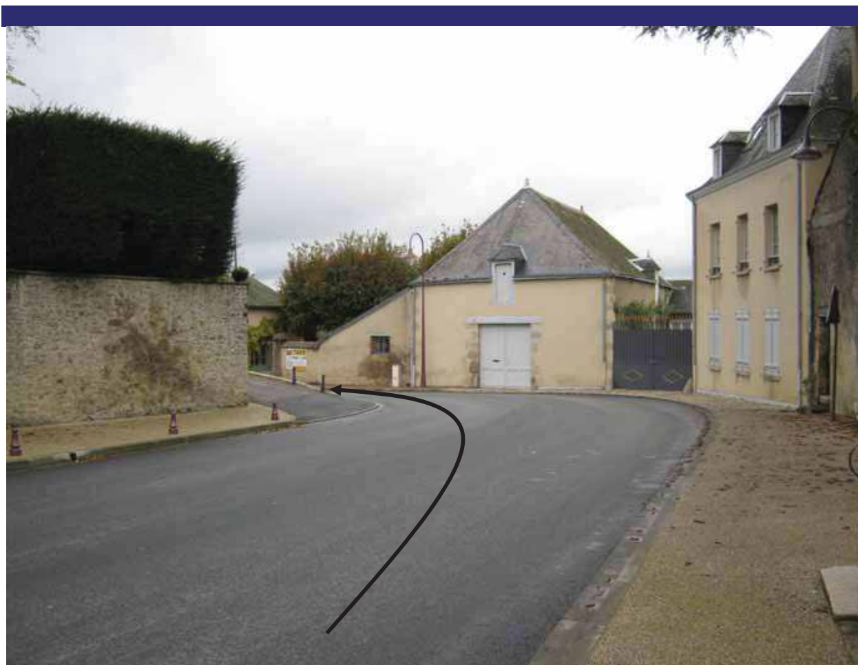
Cette photo illustre toujours le point bloquant que nous avons rencontré à St Benoît du Sault. Il s'agit du second virage dans ce village qui nous permet d'écarter, de nos solutions, la sortie 20 de l'A20.
