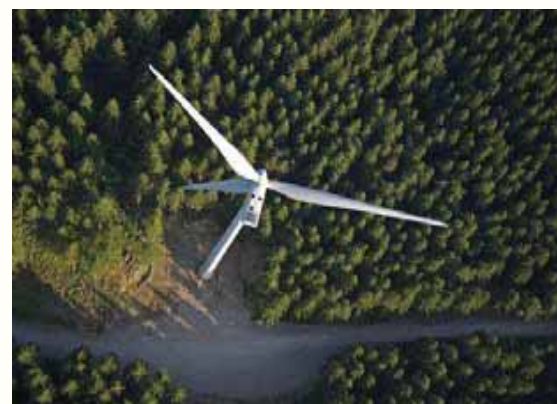
Vue du ciel d'une éolienne en milieu forestier
